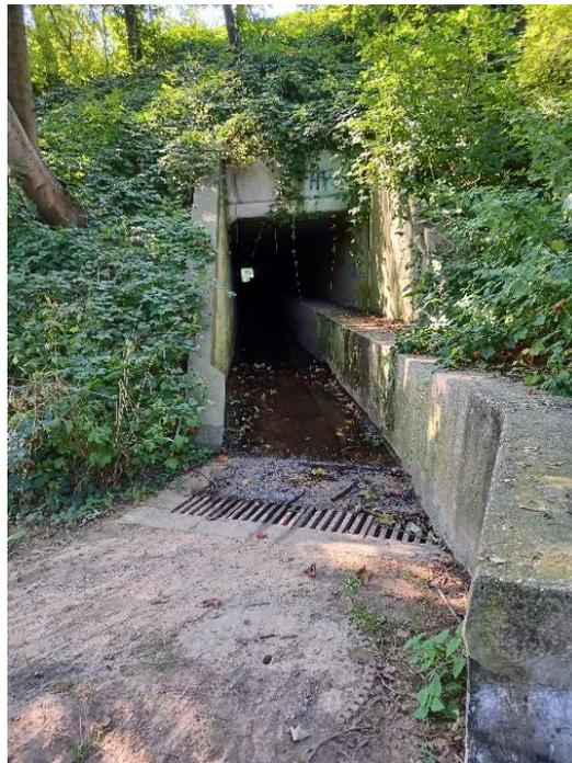
Figure 14 : Tunnel de collecte des eaux passant sous l'autoroute A4 et taques d'égout
