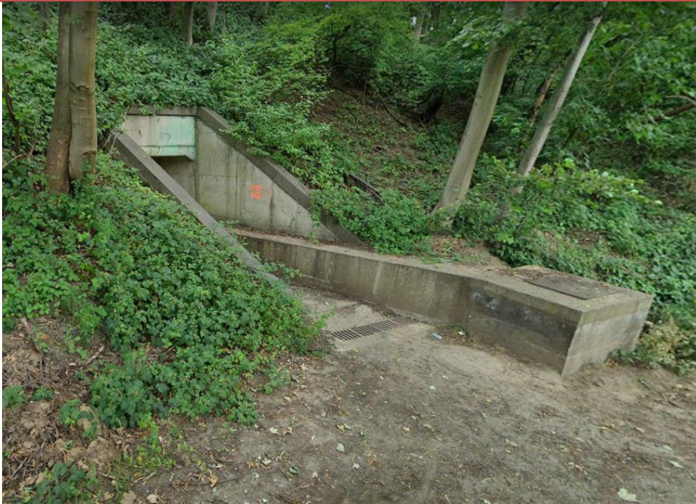
Figure 14 : Photo a - Emplacement présumé du cours d'eau (Google Street View, 2020)
