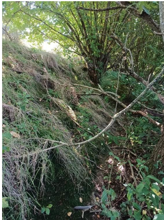
Figure 15 : Photo b - Fossé sous cordon ligneux
