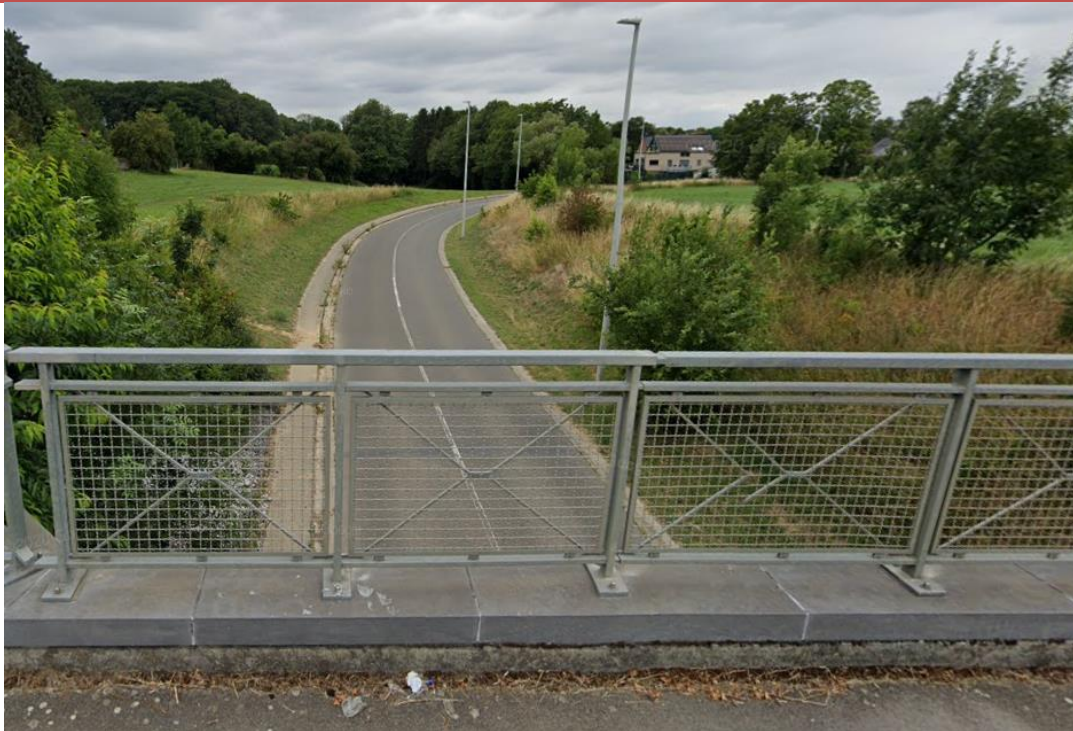
Figure 17 : Photo c - Partie route de l'axe de ruissellement concentré n°1 (source : Google Street View, 2020)
