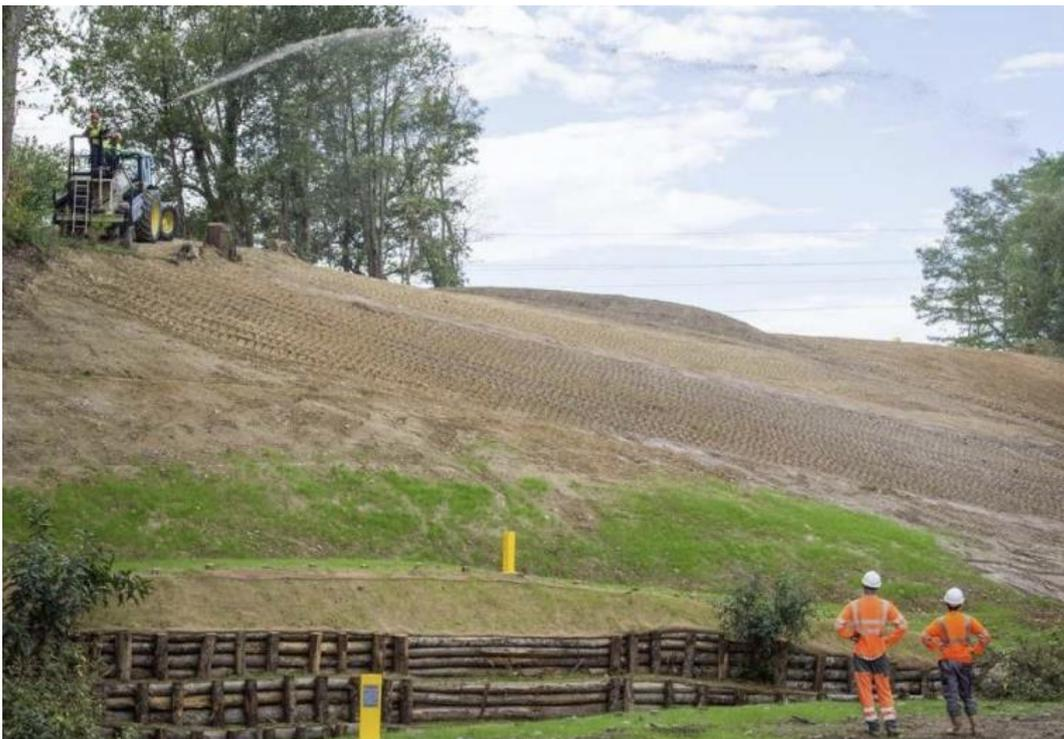
**Figure 3 : Exemple d'hydroseeding sur un talus (Source : ONEMA, 2016<sup>2</sup>)**
