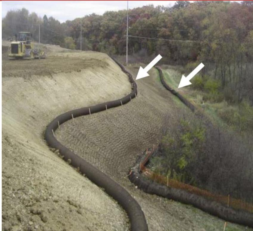
Figure 6 : Exemple de boudins sur un talus (Source : ONEMA, 2016<sup>5</sup>)
