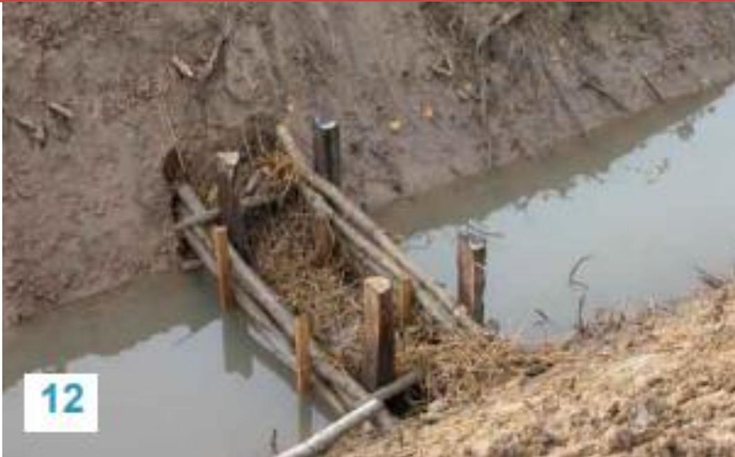
**Figure 8 : Exemple de filtre à paille (Source : CEREMA, 2015<sup>7</sup>)**
