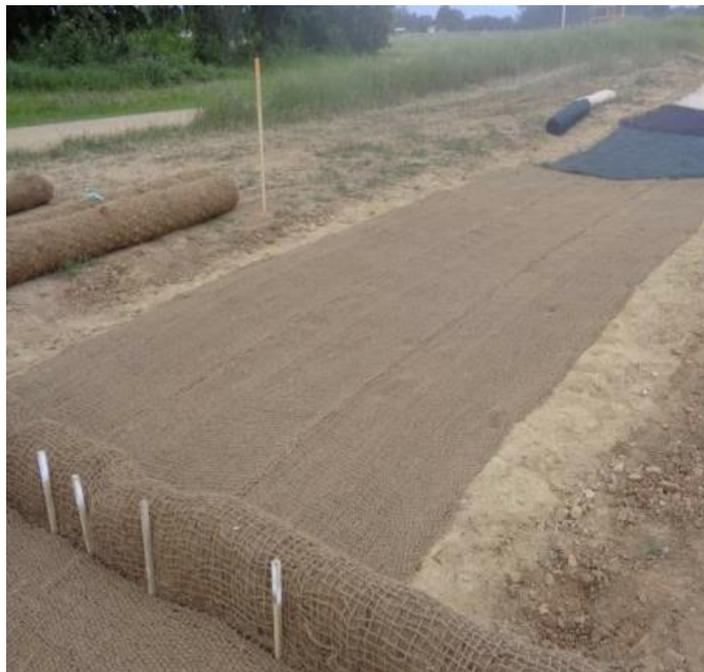
Figure 5 : Exemple de recouvrement d'un sol nu par un géotextile (Source : ONEMA, 2016<sup>4</sup>)
