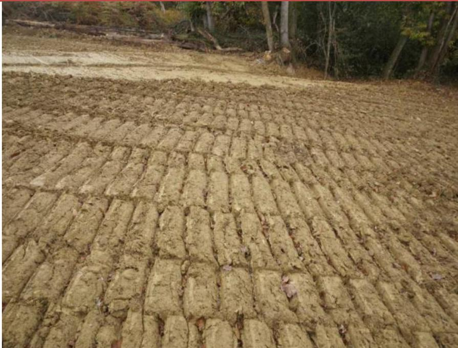
**Figure 2 : Sillons perpendiculaires aux pentes (Source : ONEMA, 2016<sup>1</sup>)**
