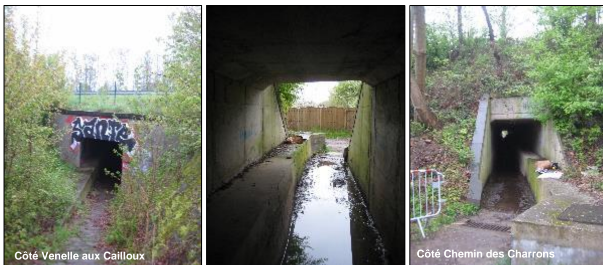
Figure 150 : Passage sous la E411 (source : Photos Stratec – 25/04/23)
