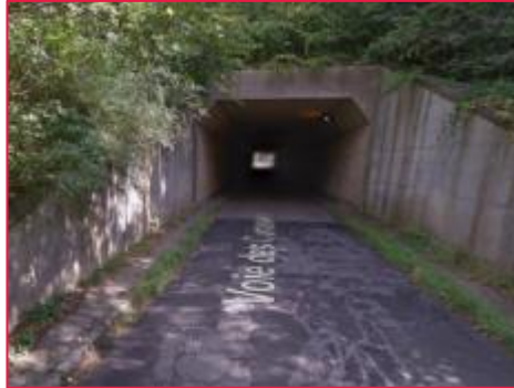
Figure 154 : Passage de la voie des Cuirassiers sous la E411 (source : Google Street View)
