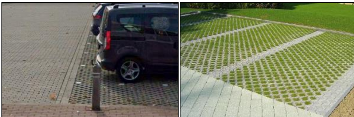
Figure 141 : Exemple de places de stationnement en dalles gazon et de voies de circulation en pavés drainants 21 (sources : Google Maps et www.bricozone.be )
