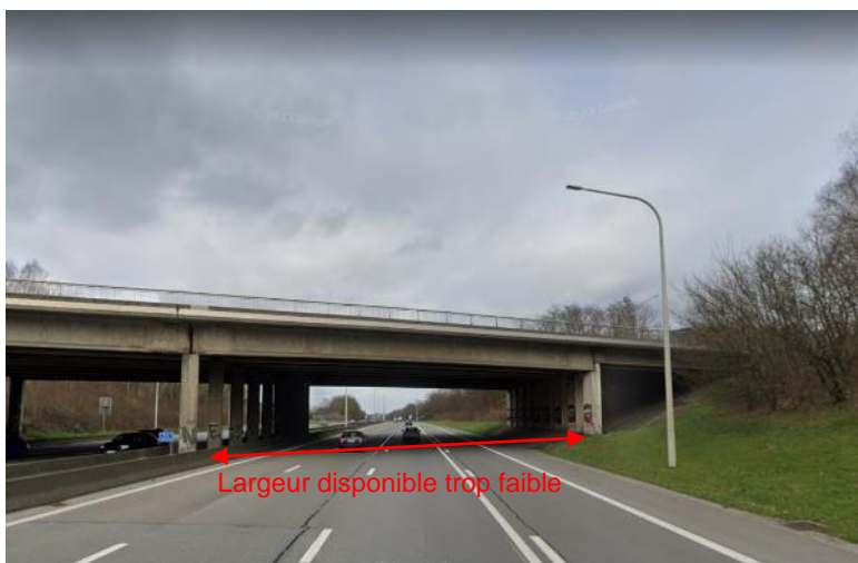
Figure 223 : Largeur disponible sous le pont de l'autoroute
