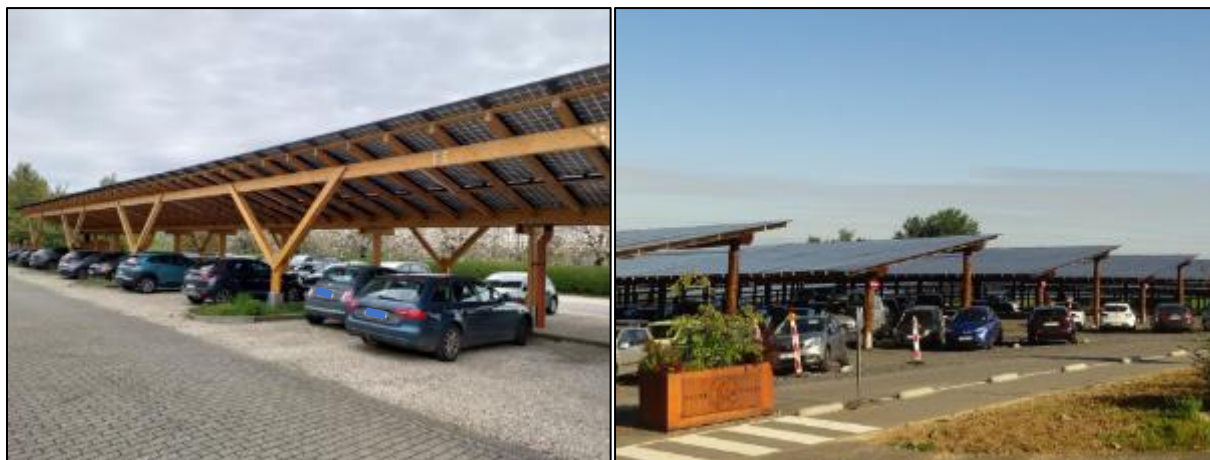
Figure 142 : Exemple de structure bois support de panneaux photovoltaïques dans un parking à Wavre (à gauche) et à Pari Daiza (à droite) (sources : Stratec, Google Maps)
