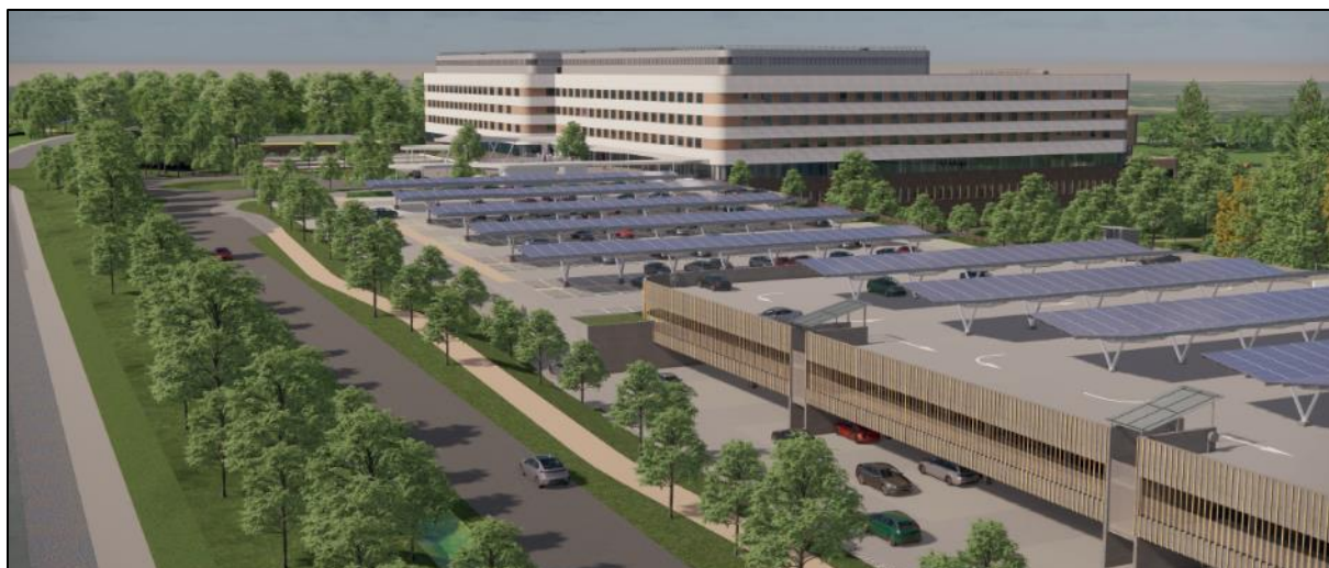
Figure 397 : Vue depuis l'angle sud-est du site, avec le parking au premier plan (source : assar architects)
