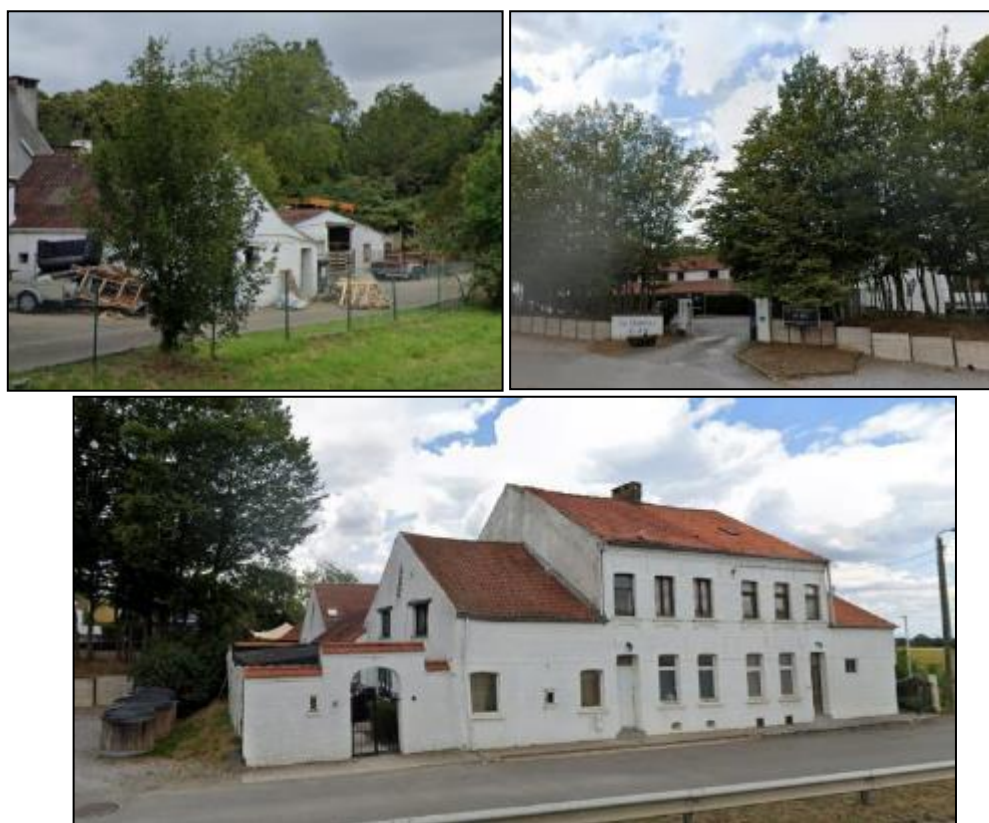
Figure 83 : Différentes vues du Domaine du Blé (source : Google Street View)
