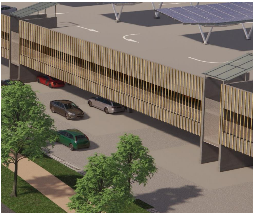
Figure 401 : vue rapprochée du claustra en bambou (source : Assar architects)
