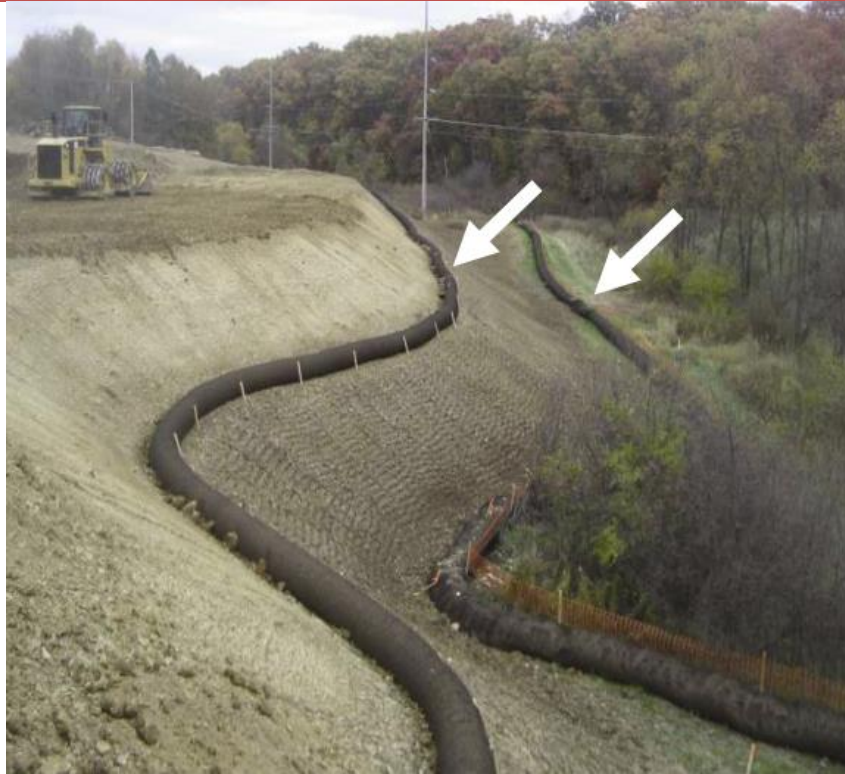
Figure 6 : Exemple de boudins sur un talus (Source : ONEMA, 2016 5 )
