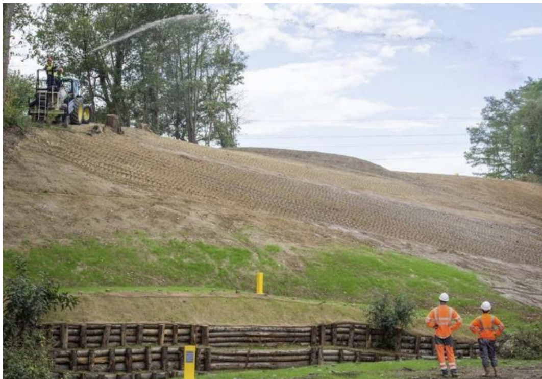
Figure 3 : Exemple d'hydroseeding sur un talus (Source : ONEMA, 2016 2 )
