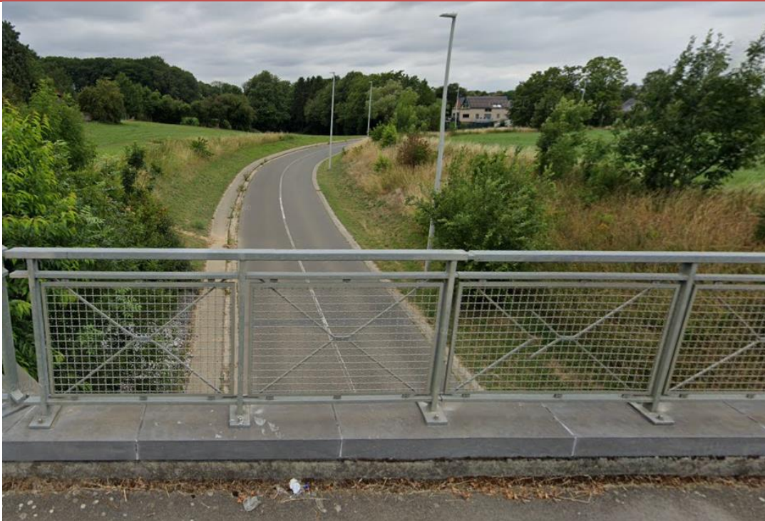
Figure 17 : Photo c - Partie route de l'axe de ruissellement concentré n°1 (source : Google Street View, 2020)
