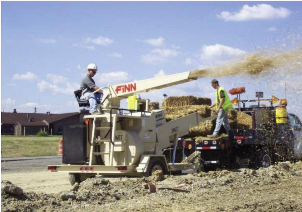
Figure 4 : Exemple de paillage d'un sol nu par projection (Source : ONEMA, 2016 3 )
