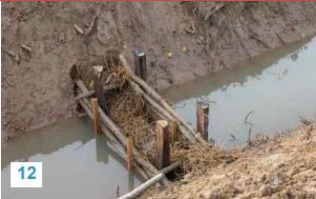
Figure 8 : Exemple de filtre à paille (Source : CEREMA, 2015 7 )
