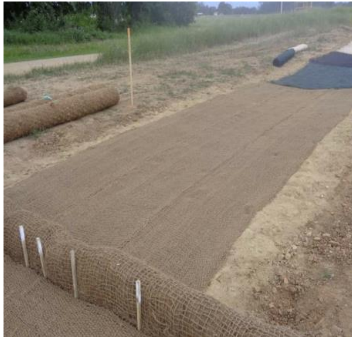
Figure 5 : Exemple de recouvrement d'un sol nu par un géotextile (Source : ONEMA, 2016 4 )
